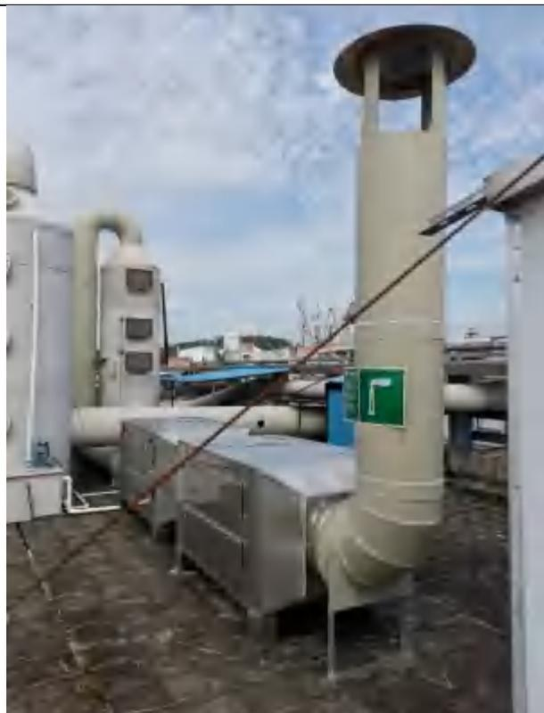
“碱液喷淋+除雾装置+二级活性炭吸附”废气处理装置
